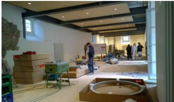
*Die Akustikplatten wurden montiert und die Stahlträger indirekt beleuchtet.*
