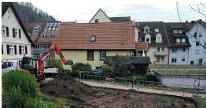
Die Arbeiten werden vom Städtischen Bauhof bewerkstelligt: Hangseitig vom Kurgartenhotel wird mit Bruchsteinen gesichert und die Fläche mit Randsteinen eingefasst. Anschließend erfolgt eine Schotterung als Parkbelag. Zusätzlich wird zur Entwässerung ein Regeneinlaufschacht neu gesetzt. Zur Abgrenzung wie auch aus Sicherheitsgründen, wird schließlich ein Holzgeländer um die Stellfläche herum montiert.
