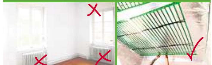
Mit wasserführenden Kapillarnetzen
