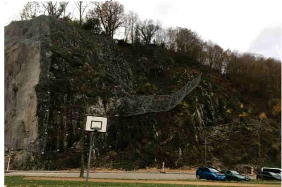
Die fertig gesicherte Felswand mit den Aufliegenden Netzen und aufgestellten Schutzzäunen
