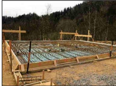
5. Sanitärraum: Herstellung Wasseranschluss; Vorarbeiten Estrichverlegung und Fliesenarbeiten
