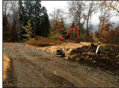
3. Verlegung der Ver- und Entsorgungsanlage vom Übergabeschacht zum Bauplatz
