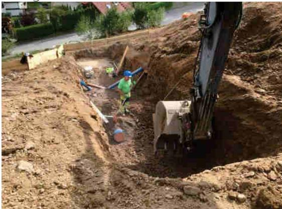
Fa. Bonath beim Verlegen der Versorgungsleitungen im steilen und felsigem Gelände
