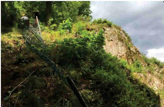
Vor Beginn der Felsicherungsarbeiten musste die Felskante freigeschnitten werden an der die schweren Netze anzubringen waren.
