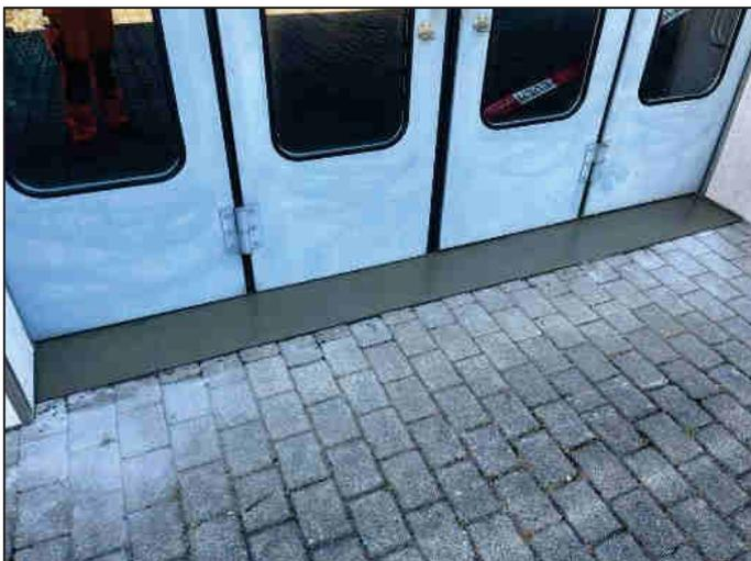
Bodangleichungsarbeiten vor Einbau neues Tor Feuerwehrgerätehaus Wolfach
