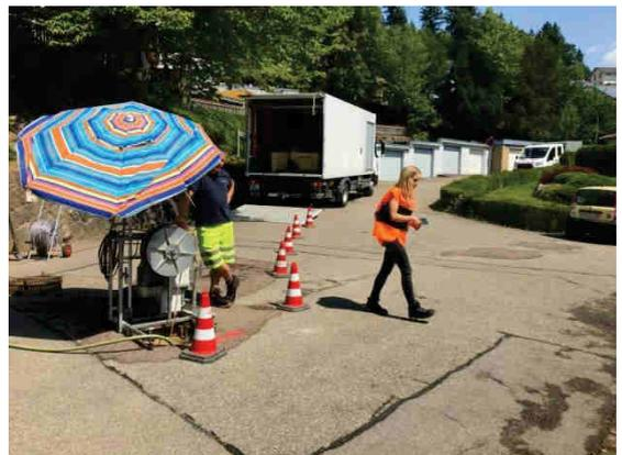
Die Firma Jeschke Umwelttechnik beim Einziehen des Inliners in das Kanalrohr in der „Unteren und Oberen Rebberstraße“. Die Maßnahmen sind von außen kaum sichtbar, entfalten im Kanallinneren aber eine große Wirkung.
