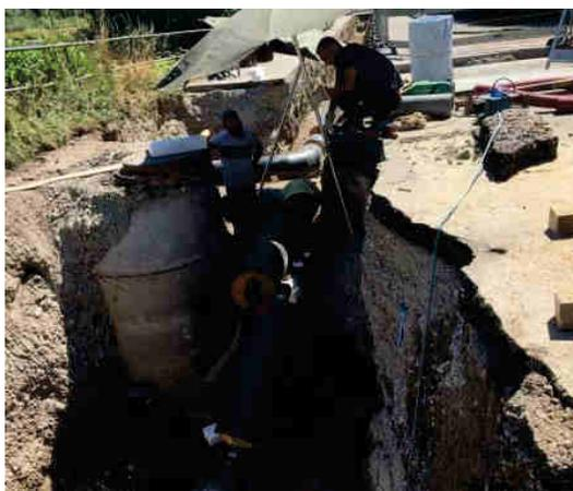
Verlegung der Wärmeleitung im Herlinsbach und Mitverlegung von 145 m Wasserleitung bis zur Wolfenbrücke
