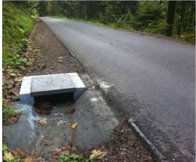
Bei den Arbeiten wurde punktuell der schlechte Untergrund durch tragfähiges Material ersetzt. Entwässerungseinrichtungen wurden saniert und zusätzlich Ableitungen eingebaut. Um den unebenen Straßenbelag wieder in Form zu bringen, wurde eine Profilausgleichsschicht aufgebracht und darüber eine 8 cm starke Tragdeckschicht aufgetragen.
