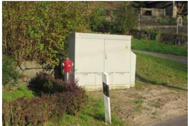
*Zwei solcher Verteilerkästen wurden in Kirnbach und einer im Langenbach installiert und mit Glasfaserleitungen angesteuert. Von dort aus werden die Haushalte über das Telefonnetz mit DSL versorgt. Da mit zunehmender Entfernung die Übertragungsrates sinkt und früher alle Haushalte über den Zentralverteiler in der Bahnhofstraße angebunden waren, gab es in den hinteren Seitentälern keine Internetverbindung. Diese Zeiten gehören der Vergangenheit an.*
