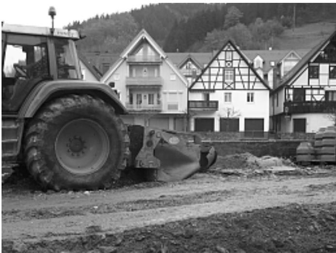
mit 310 PS wurden die Wurzelstöcke rausgefräst
