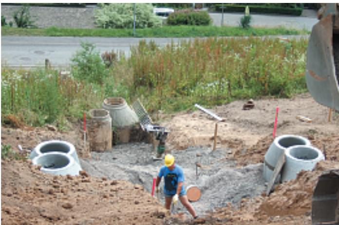
...im nächsten Schritt dann die Kanalschächte und -rohre verlegt,
