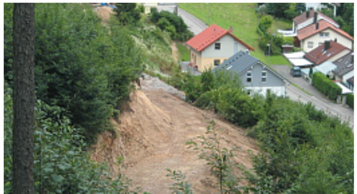
Hierfür musste in Verlängerung der Hofbergstraße auf weiteren 90 Metern Länge eine Behelfstraße geschoben, darin die Wasserleitung verlegt und diese schließlich an die Leitung des Hochbehälters Straßburgerhof angeschlossen werden. Damit kann das Wasser nun schon vor dem ersten Anschluss eines neuen Hauses zirkulieren und wird dabei immer ausgetauscht.
