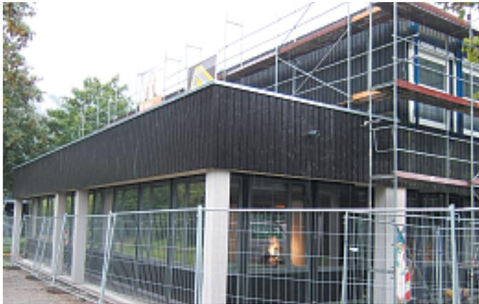
Beim Lehrerzimmeranbau wurde in den vergangenen Wochen die Holzschalung angebracht sowie die Dachabdichtung fertiggestellt. Die Fenster- und Fassadenarbeiten sind somit beendet. Auch die Heizungsrohre und der Estrich sind verlegt.
