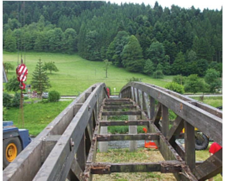
*Brückenkonstruktion ohne Belag und Handlauf*
