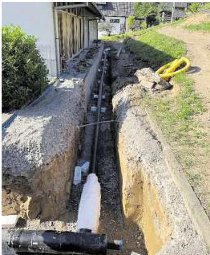
Parallel zu den Arbeiten Am Lindenplatz und in der Friedensstraße wurde durch eine weitere Tiefbaukolonne der Wärmeleitungsbau im Birkenweg weiter vorangetrieben. Die erste Hälfte des Abschnittes ist fertiggestellt und wieder verfüllt. Im zweiten Abschnitt sind die Arbeiten beim Rohrleitungsbau in den letzten Zügen.
