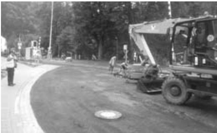
*Asphalttragschicht, Gehweg und Entwässerungsrinnen waren Anfang der Woche bereits fertig. Die Asphaltdeckschicht soll bis Ende der Woche folgen. Die sicherheitstechnischen Einrichtungen wie beispielsweise Lichtsignale und Schranken sind bereits betriebsbereit.*
