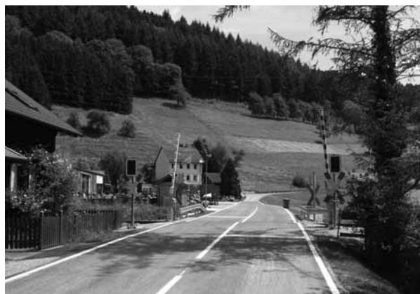
▲ Der Bahnübergang am Schmittegrundweg wurde verbreitert und mit Halbschranken versehen. Auch hier wurden Gleise, Beläge und Sicherheitstechnik auf den neuesten Stand gebracht.
