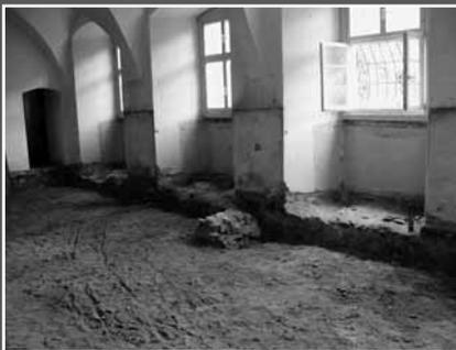
◀ Der große Saal vorher. Der Bodenunterbau wies keinerlei Isolierung auf und musste 50 cm tief ausgehoben werden. Der Putz war an vielen Stellen schadhhaft, die Fenster entsprachen nicht mehr modernen Wärmeschutzvorschriften.
