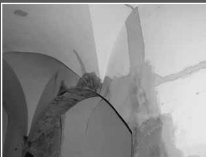
◀ Bis zu 80 Prozent originaler Putz aus der Bauzeit von 1761-71 sind in den Museumsräumen erhalten. Allerdings entstanden im Lauf der Jahrhunderte zahlreiche Risse durch Setzungen und Schäden durch Um- und Einbauten.
